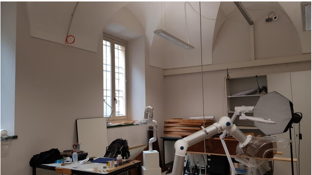
PTZ da fissare a muro, in corrispondenza del cavo di rete arancione
